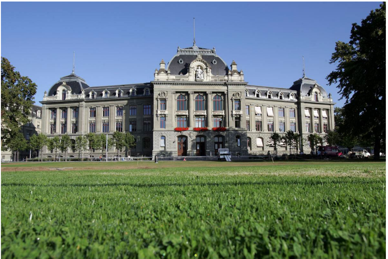
Abbildung 1: Hauptgebäude der Universität Bern
