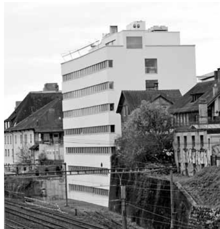
Direkt neben den Bahngleisen: Der Neubau Klinische Forschung des Inselspitals.
