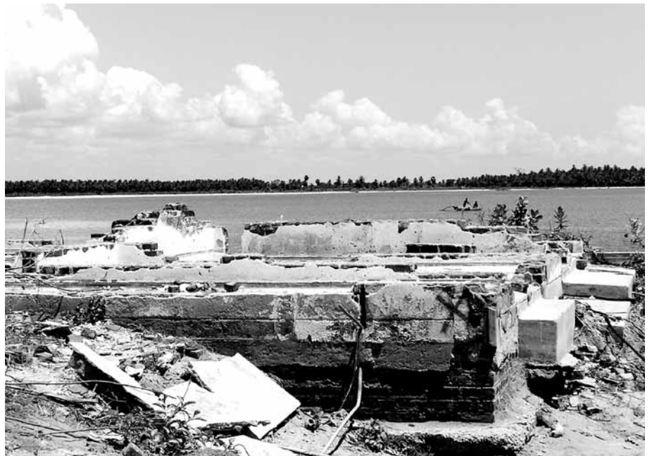
Eines der vielen zerstörten Häuser am Küstenstreifen von Batticaloa.
