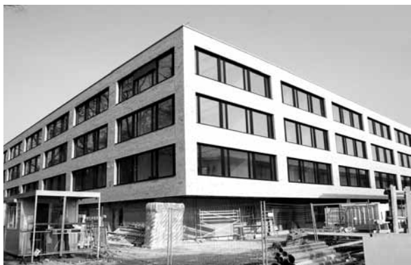
Im bald fertig gestellten vonRoll-Institutsgebäude ziehen sich die Büros den grossen Fenstern entlang.
