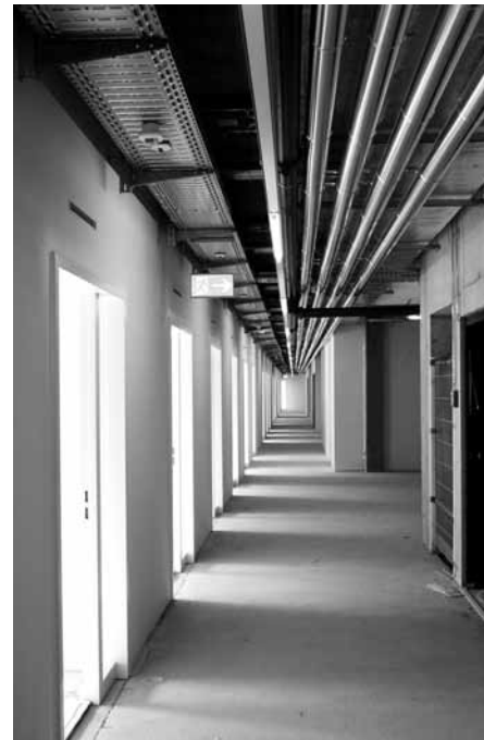
Der grosszügige Korridorbereich, hier noch im Rohzustand, wird zur Begegnungszone.
